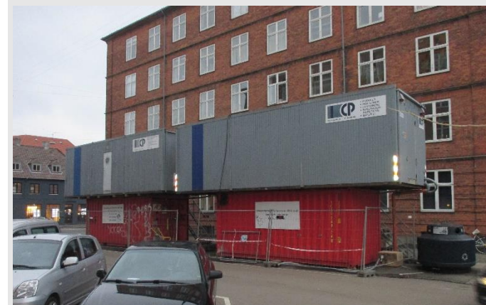
Eksempel på byggepladsforhold
