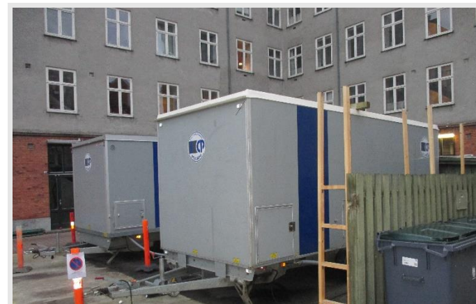
Eksempel på byggepladsforhold
