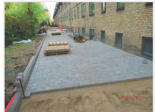
Eksempel visende nye flisebelægninger
