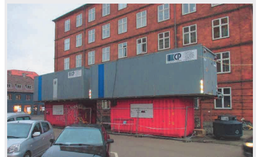
Eksempel på byggepladsforhold
